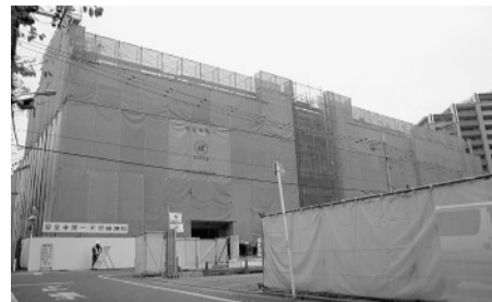
小豆沢四丁目に建設中の特養ホーム
